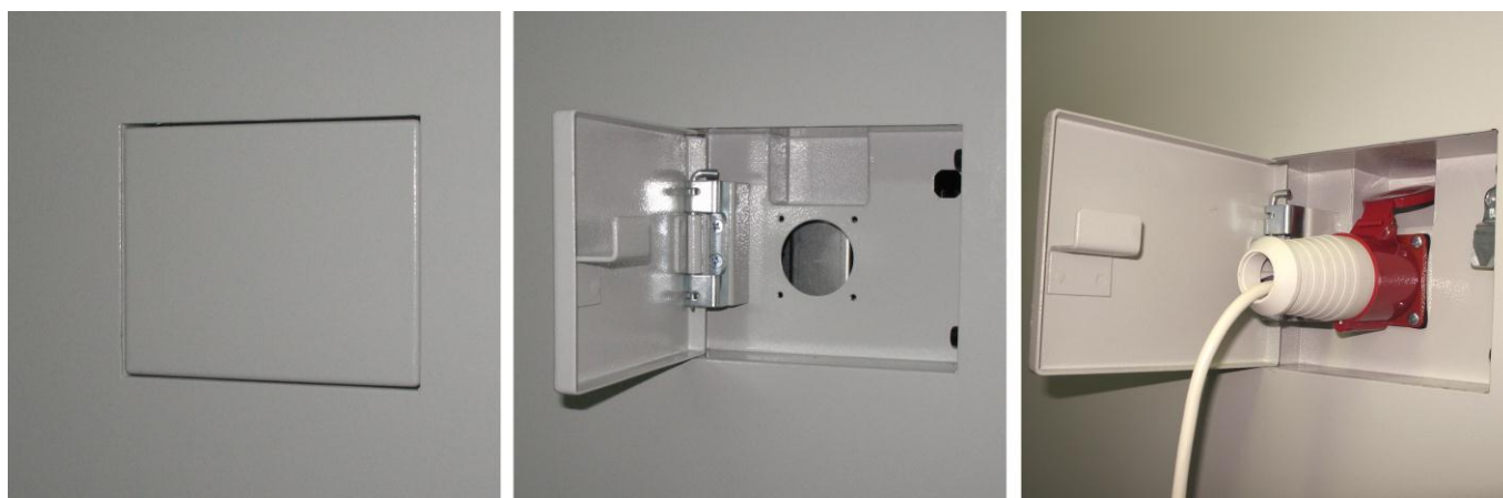
Отсек с вилкой для подключения ДГУ
